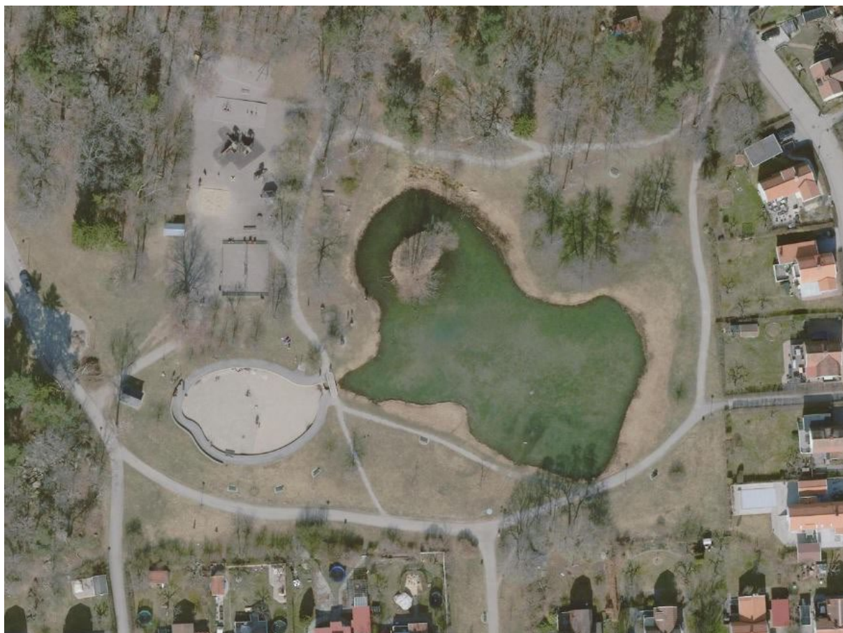
Figur 1. Olovslundsdammen med den angränsande plaskdammen till vänster i bilden. Muren längs den västra kortändan av plaskdammen kan skönjas i bilden. Ortofoto 2020 från Stockholms stadsbyggnadskontor.
