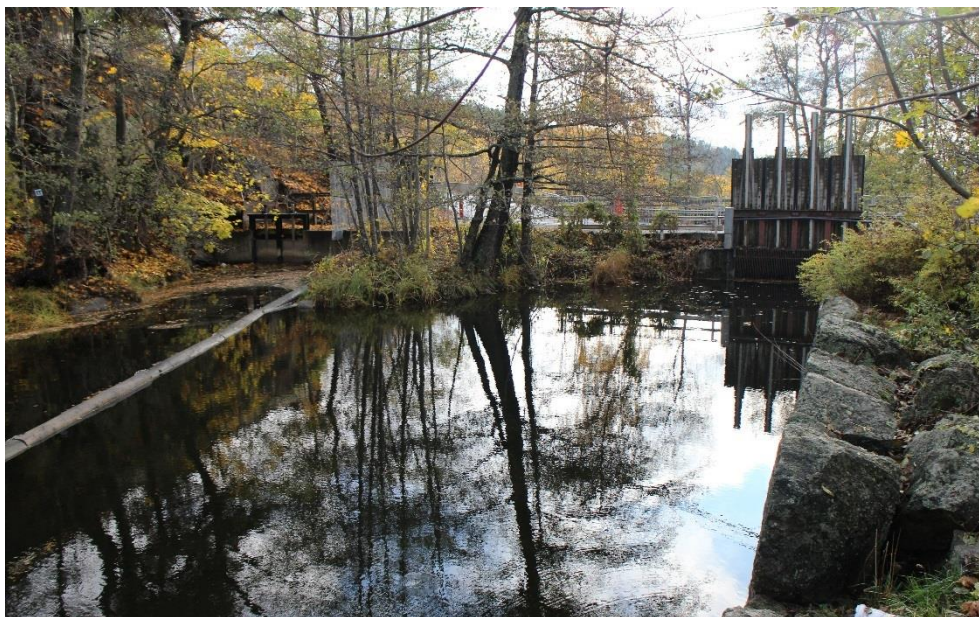
Figur 21. Dambyggnaden vid Uddby kraftverk med utskov till vänster och intag till höger. Norconsult 2016.
