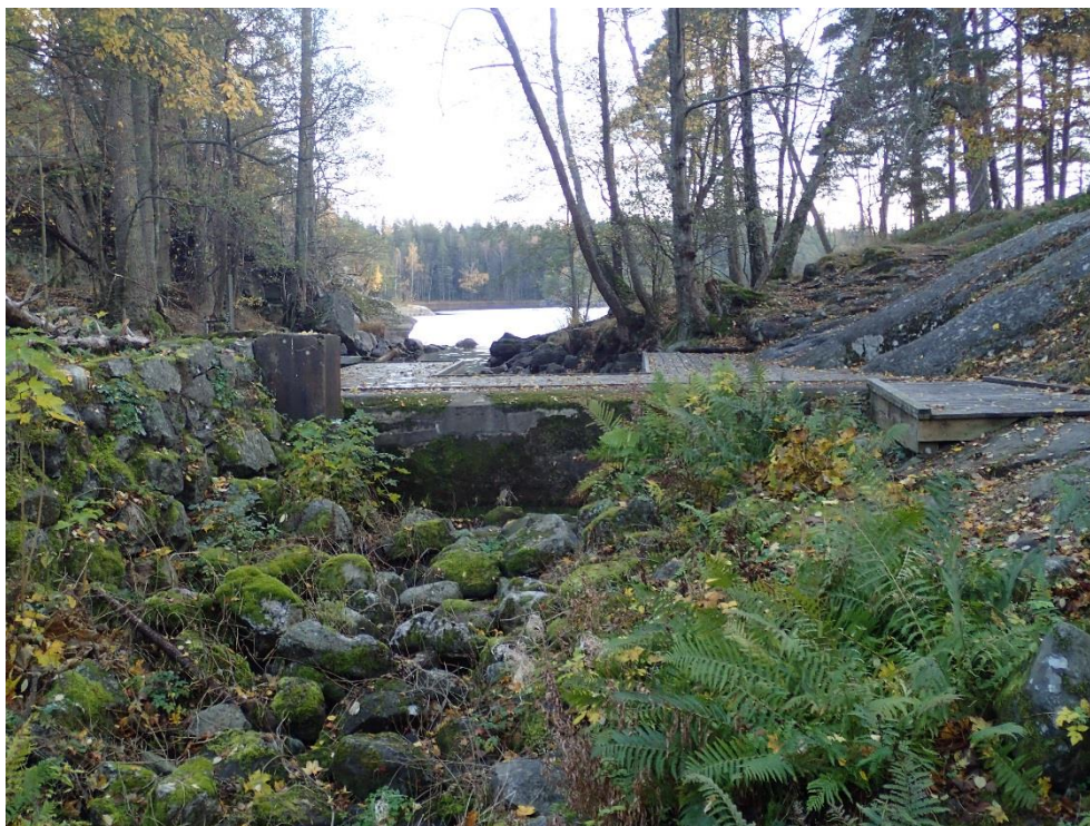
Figur 28. Till vänster om Kvarndammen finns en anslutningsdamm i betong som är i dåligt skick. Vat- ten tränger fram under konstruktionen. Ovan dammen i bild finns en upptagningsplats för kanoter. Norconsult 2016.
