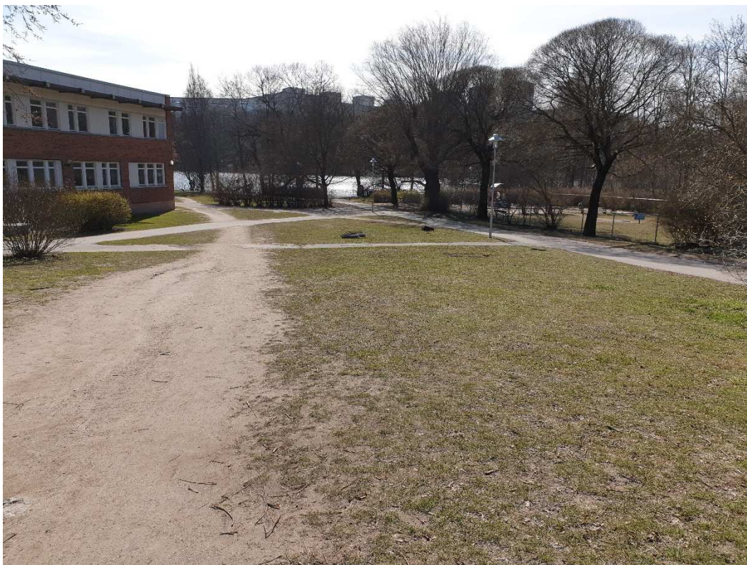
Figur 20. Området där kulverten som föreslås öppnas upp och byggas om, som är utloppet från Trekanten. Kulverten går några meter under marken. Bilden visar även att marken lutar ner mot Trekanten, vilket medför att kulverten går djupare i marken ju längre från Trekanten den är. Det ursprungliga utloppet var troligen under byggnaden till vänster i bilden.
