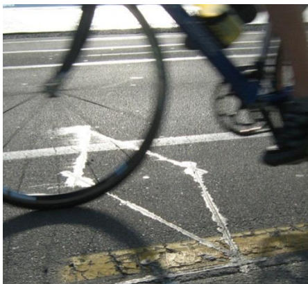
Figur 2: Cyklar räknas automatiskt av slingor som ligger nedfrästa i asfalten.
