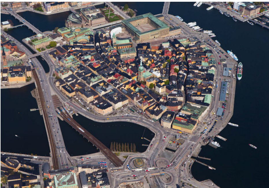
Mälarens vattennivå regleras i Stockholm och i Södertälje genom att vatten från sjön släpps ut till havet. Nya Slussen kommer att ha dubbelt så stor kapacitet att avvattna Mälaren än dagens lösning.
