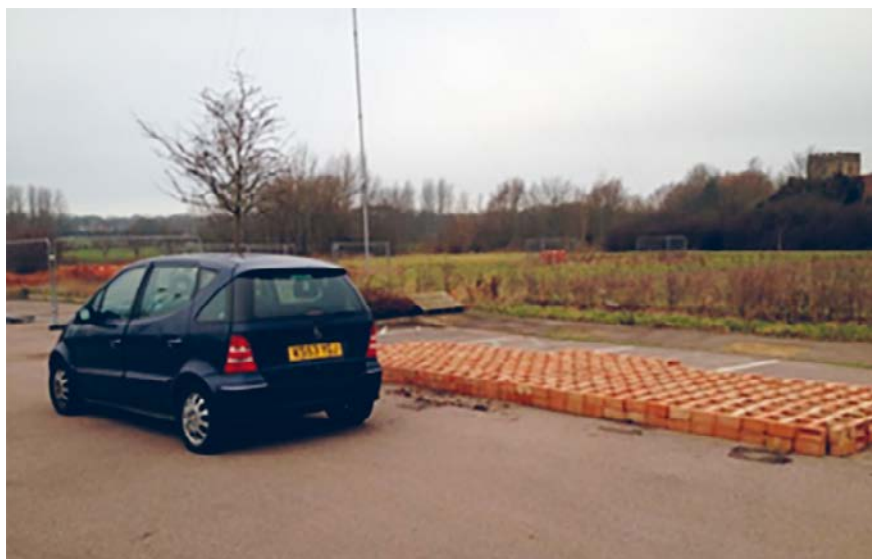
Bullerreducering med hjälp av markbehandling. Foto: Hosannaprojektet.
