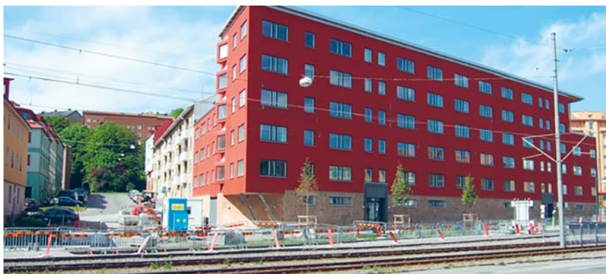
Kvarteret Örlen i Göteborg efter förtätning. Ny byggnad med genomgående lägenheter. Byggnaden minskade ljudnivån på gården med 6–10 dBA. Foto: Ljudlandskap för bättre hälsa.
