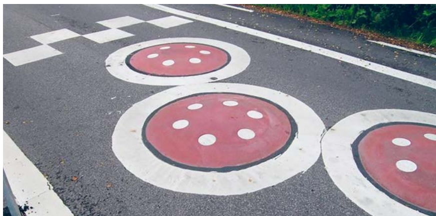
Farthinder "Mushroom", färdiga betongelement som monteras i befintlig asfalt. Foto: Exempelbanken.se
