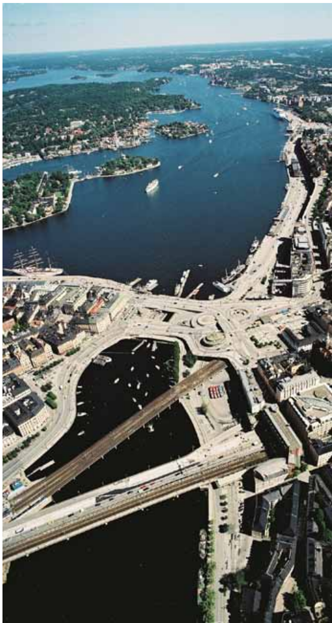
Slussen i Stockholm. Foto: Stockholms stadsbyggnadskontor
