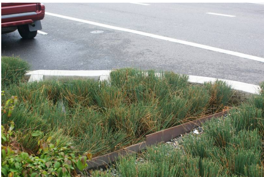
Bild 5. Dämme av cortenstål i växtbädd i Portland, Oregon, USA, 2010
