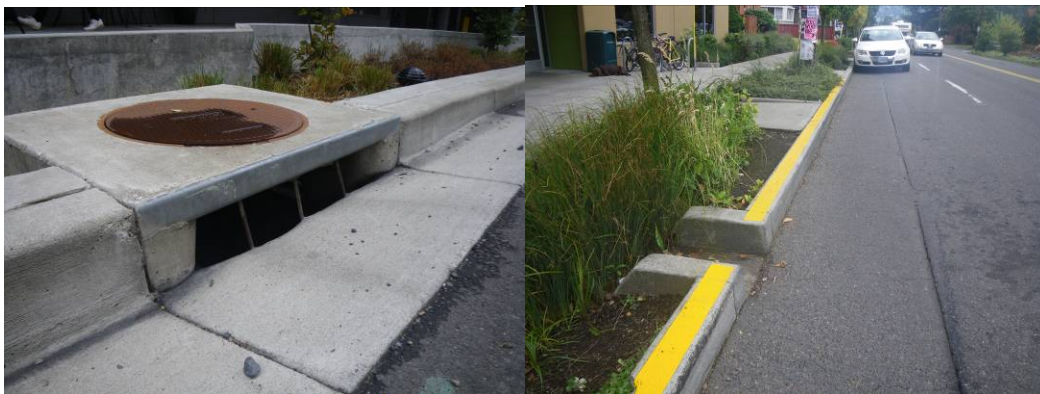
Bild 9. 90-gradiga inlopp i Portland, Oregon, USA. Erfarenheterna ifrån dessa inlopp är att stor del av flödet rinner förbi istället för in i inloppet.
