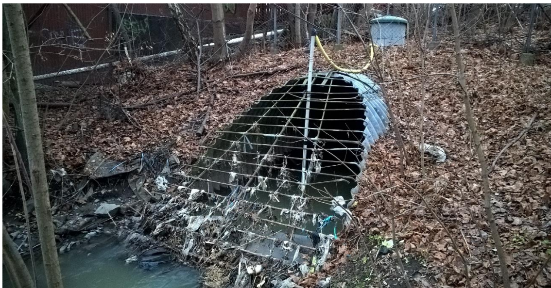
Figur 3-2 Nedströmsdel av kulverterad sträcka av Ballstaån vid Mjölnerstigen (utloppet från bergtunnel under Spånga centrum).
