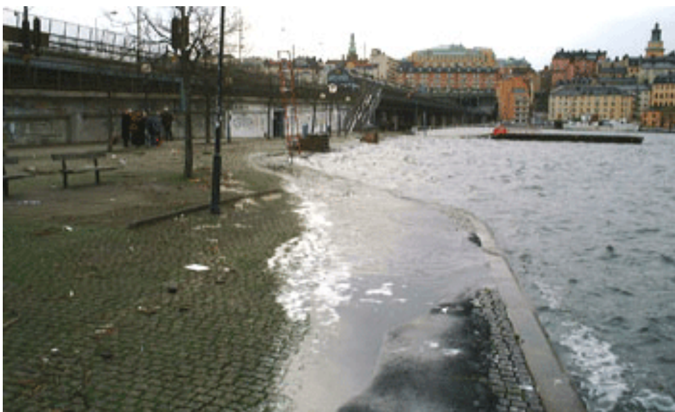
Figur 10: Översvämning från Mälaren nära att tränga in i Gamla Stans tunnelbanestation. Foto: Länsstyrelsen i Stockholm
