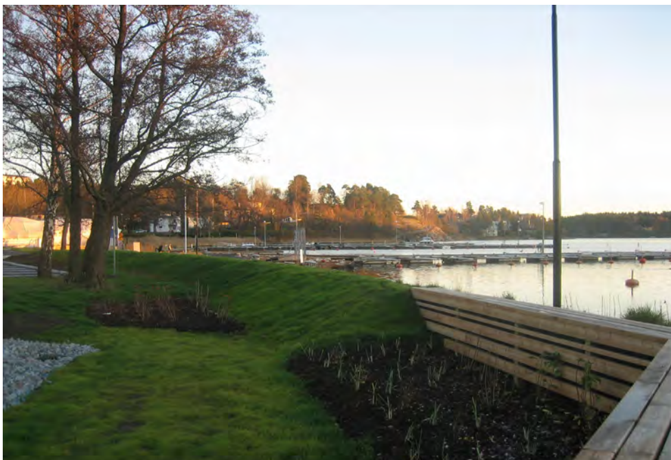
Figur 21: Översvämningsskydd vid Nora Strand, Danderyds kommun. Källa: Danderyds kommun.
