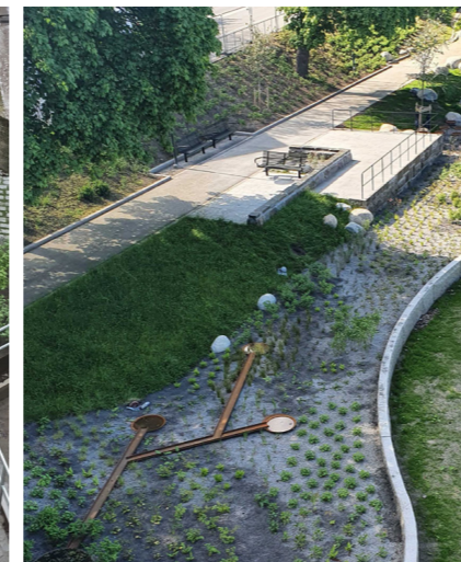
Regnparken - biofilter med vattenspel.
