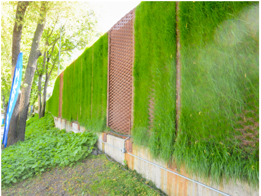
På platser där det krävs bullerskydd eller stödmurar kan gröna lösningar användas. Här är ett bullerskydd där gräs och örter växer vertikalt och skapar en grönare miljö.
