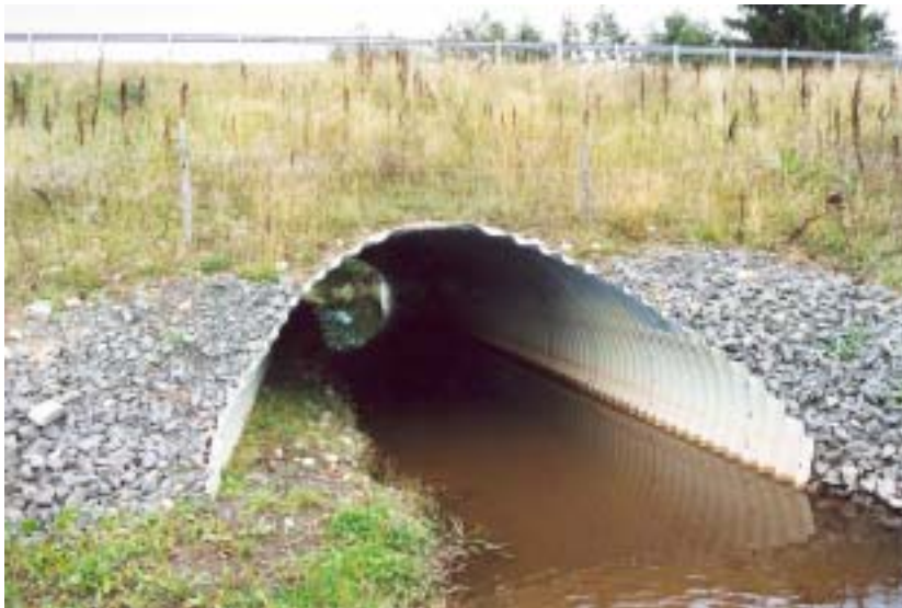
Figur 1. Vägtrumma anpassad för passage av landlevande smådjur. En strandremsa rymmer i trumman. Exempel på åtgärdskategori 2 i tabell 1.
