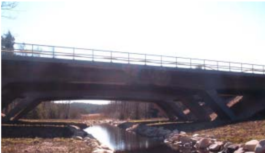
Figur 3. Landskapsbro för motorväg över ett vattendrag i närheten av ett rikt naturområde. Bron fungerar både som faunapassage och för det rörliga friluftslivets passagebehov. I närheten planeras en rastplats. Exempel på åtgärdskategori 3 i tabell 1.
