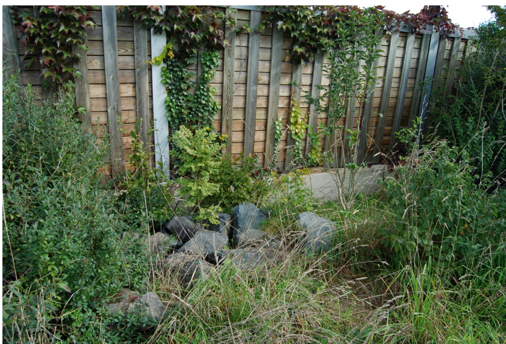
Figur 23. Exempel på avskärmning i trä med växtlighet på, från en ekodukt i Frankrike. Stenarna framför skärmen bildar en torr miljö som uppskattas av kräldjur, insekter och många ångsväxter. Foto: Mats Lindqvist (Trafikverket).
