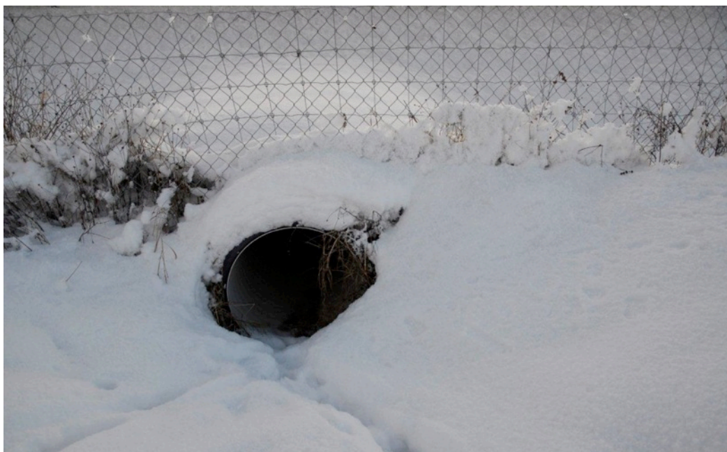
Figur 24. Faunastängsel ovanpå viltstängsel invid en trumma under vägen. Foto: Mats Lindqvist (Trafikverket).
