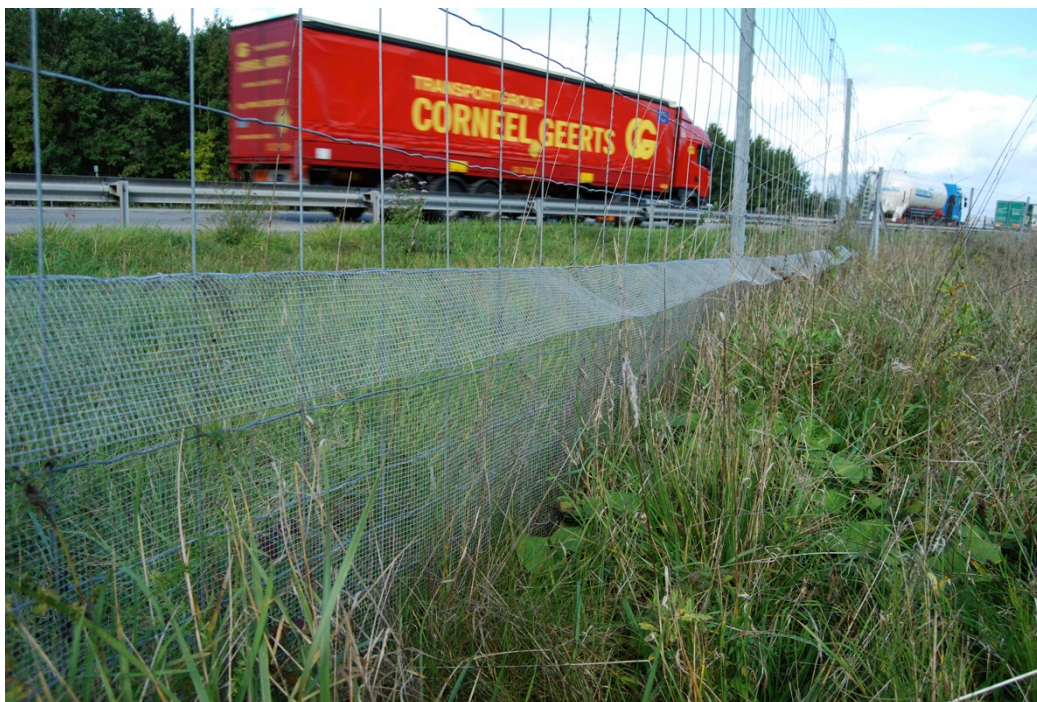
Figur 26. Stängsel för hjortdjur kombinerat med finmaskigt nät för att utesluta även små djur. Den överhängande delen av nätet gör att grodor och kräldjur inte kan klättra över. Bilden är tagen i Frankrike. Foto: Mats Lindqvist (Trafikverket).
