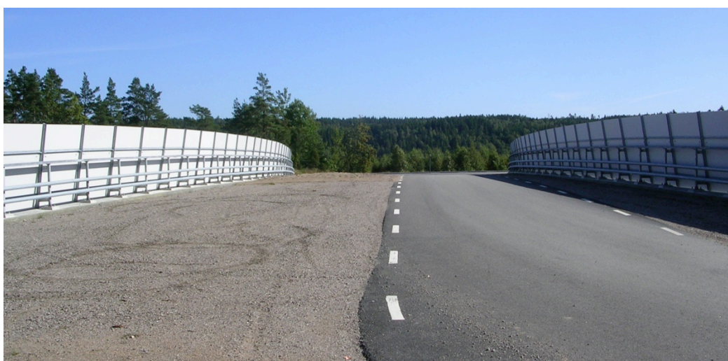
Figur 15. Ett exempel på en faunaanpassad vägbro som visserligen erbjuder större djur en passagemöjlighet, men med mycket lägre effektivitet än en ekodukt. Här leds inte naturen över vägen. Foto: Mats Lindqvist (Trafikverket).
