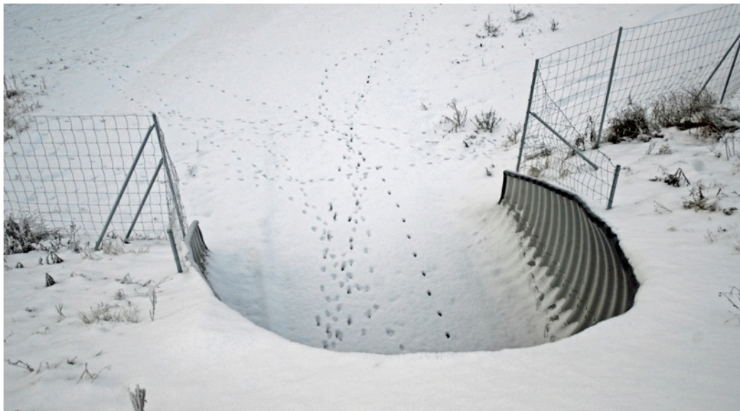
Figur 2. Spåren i snön visar att denna rörbro med en ägoväg under E6 i Bohuslän används av djur i området. Foto: Mats Lindqvist (Trafikverket).
