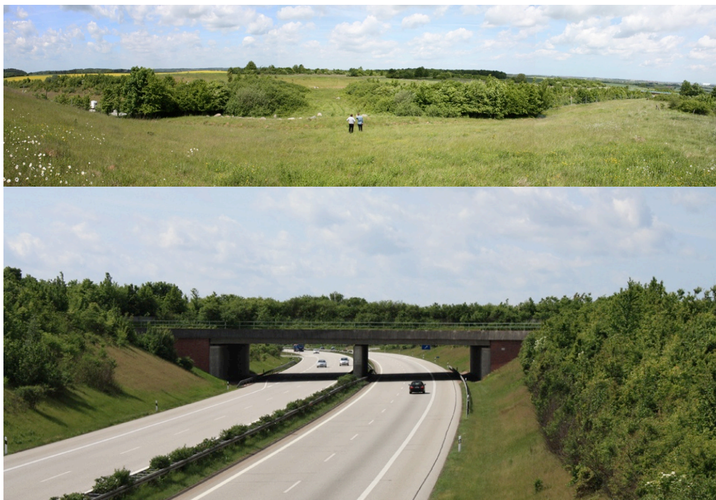
Figur 16. Naturlig passage över väg A20 vid Barnekow i norra Tyskland (övre fotot) och samma passage från väg A20 (undre fotot). Notera att vägen är nedsänkt i landskapet och att en vit lastbil på vägen syns till vänster i det övre fotot. Foto: Erik Jondelius (SLU).
