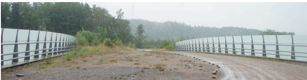
Figur 34. Faunanpassad vägbro över E6 vid Geddeknippen, norr om Uddevalla, där buskar och gräs etablerat sig självt på en kal grusyta (bild tagen cirka tio år efter brons färdigställande). Foto: Håkan Ignell (Calluna AB).
