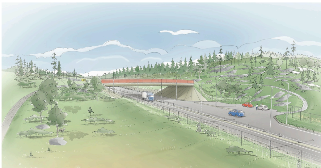
Figur 29. Planerad faunabro kombinerad med friluftsliv på Södertörnsleden, vid Stensättra ängar och Flemingsbergsskogen. En ägoväg leder över faunabron och nedanför, längs Södertörnsleden, finns parkeringar avsedda för friluftslivet. Illustration: Tecknarn i Roslagen AB.
