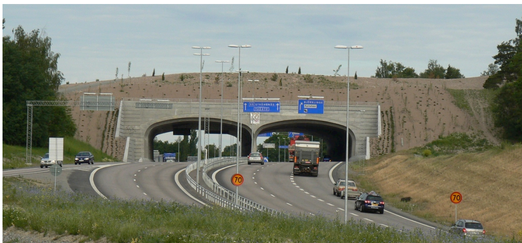
Figur 27. Kombinerad ekodukt/sociodukt som förenar två olika friluftsområden och en rullstensås i Uppsala. Bron är i första hand byggd för friluftslivet, men används även av djur i området. Foto: Jan-Olof Helldin (CBM/SLU).
