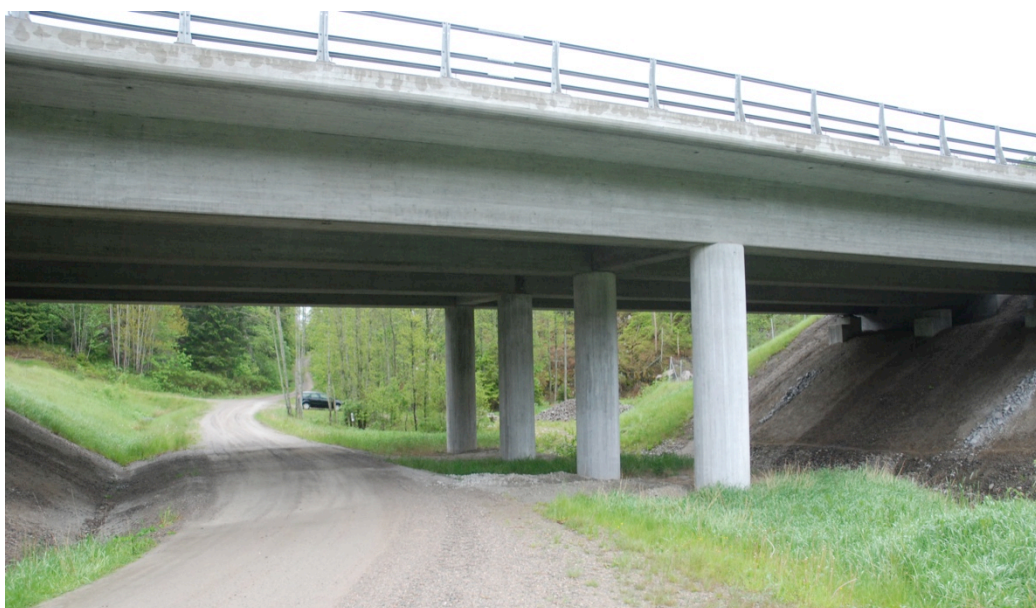
Figur 4. Passagemöjlighet under vägen. En faunaanpassad passage i en dalgång med en bäck längs E6 i Bohuslän. Foto: Mats Lindqvist (Trafikverket).
