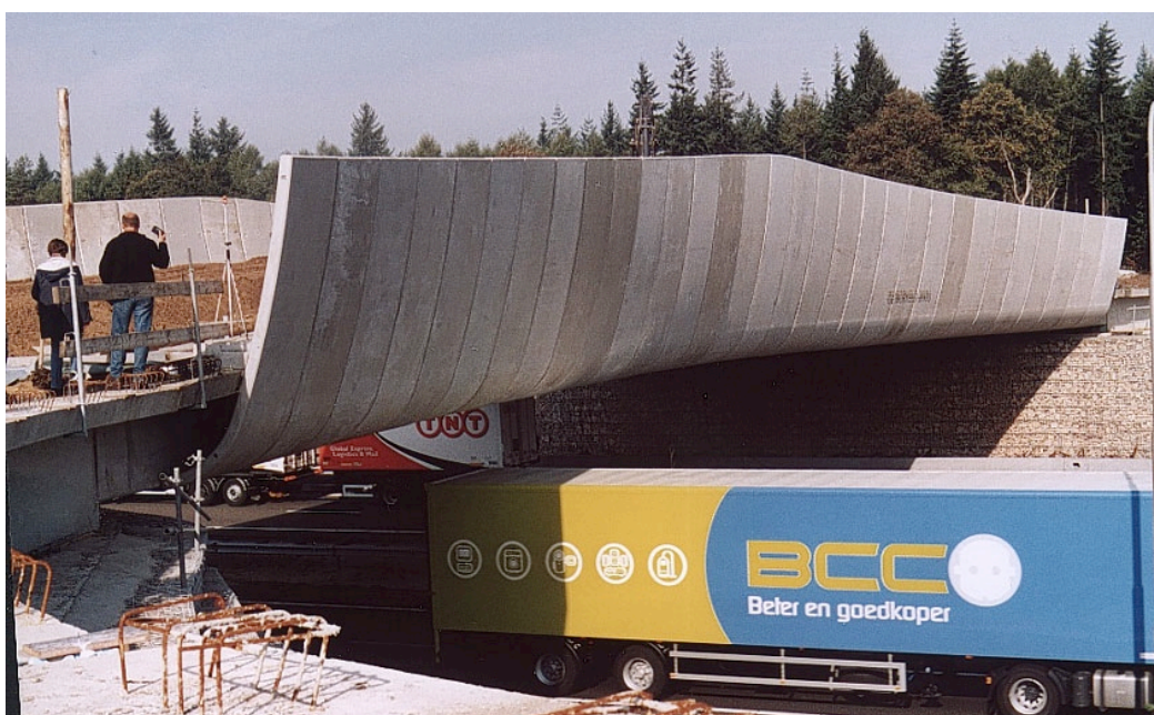
Figur 18. Faunabro under konstruktion i de Borkeld i Nederländerna. Foto: Hans Bekker (RWS).
