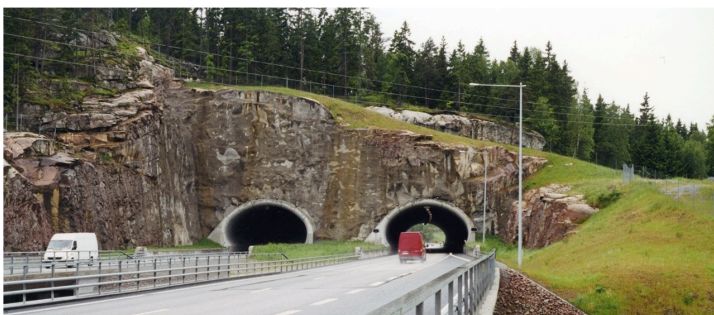
Figur 14. En ungefär 150 meter bred tunnel längs E6 i Bohuslän som skapar en naturlig faunapassage över vägen. Över tunneln finns även en ägoväg. Foto: Mats Lindqvist (Trafikverket).
