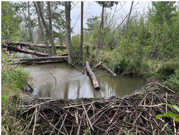
Fig. 9. Bäverdamm i Igelbäcken, under T-banebro vid Kymlinge, Sundbyberg stad. Foto: Stefan Lundberg
