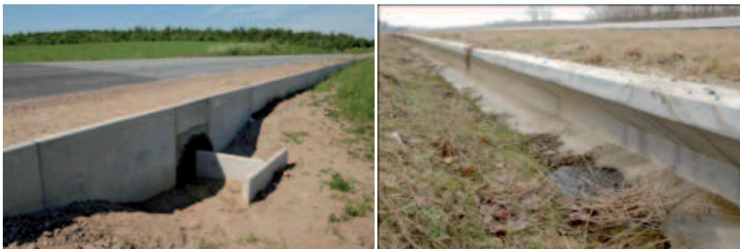
Figur 9 och 10 visar exempel på hur en groddjursbarriär kan se ut. Figur 9 visar även exempel på ett T-format styrhinder.
