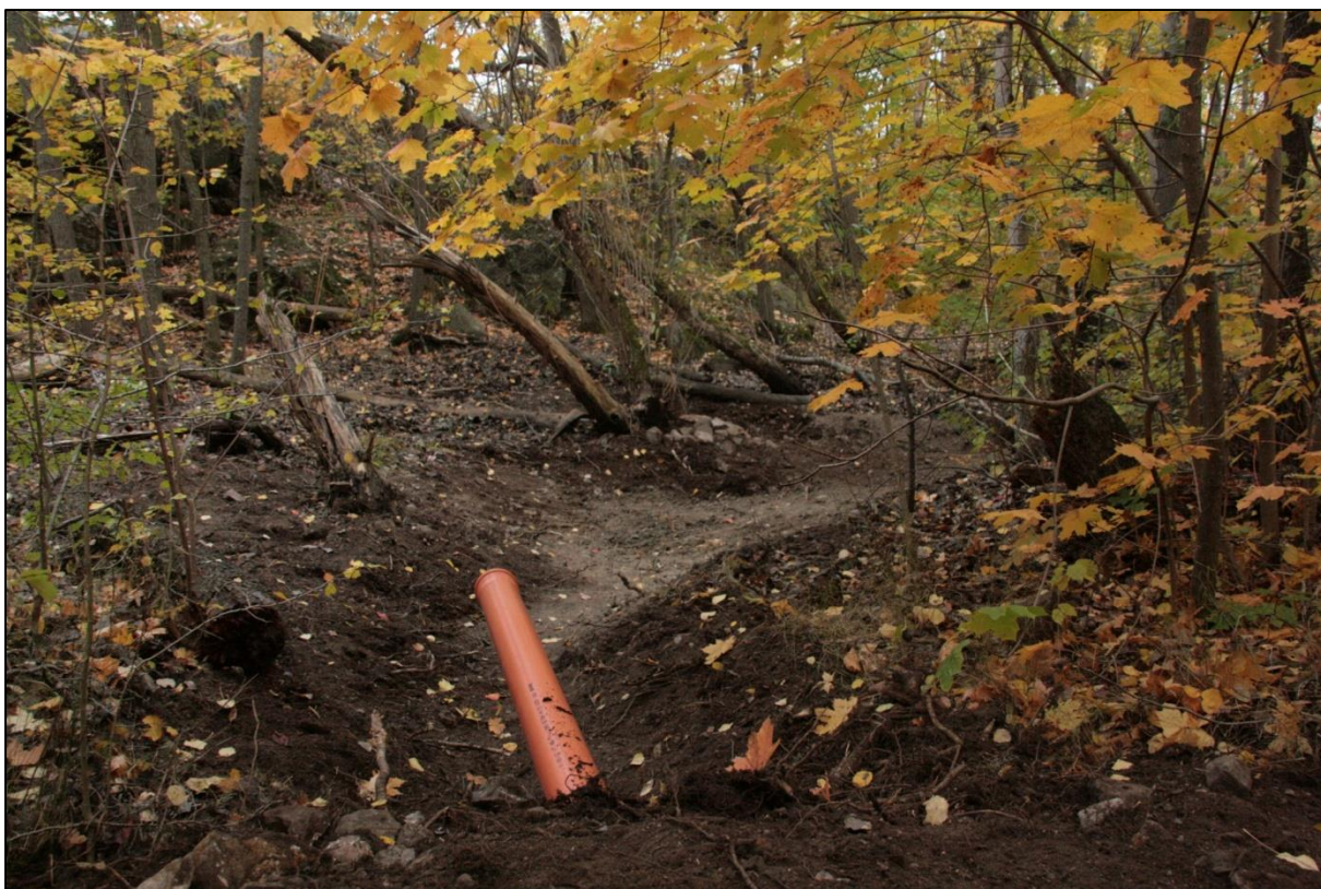
Figur 6. Fotot visar lokalen hösten 2011, strax efter att åtgärden utförts.
