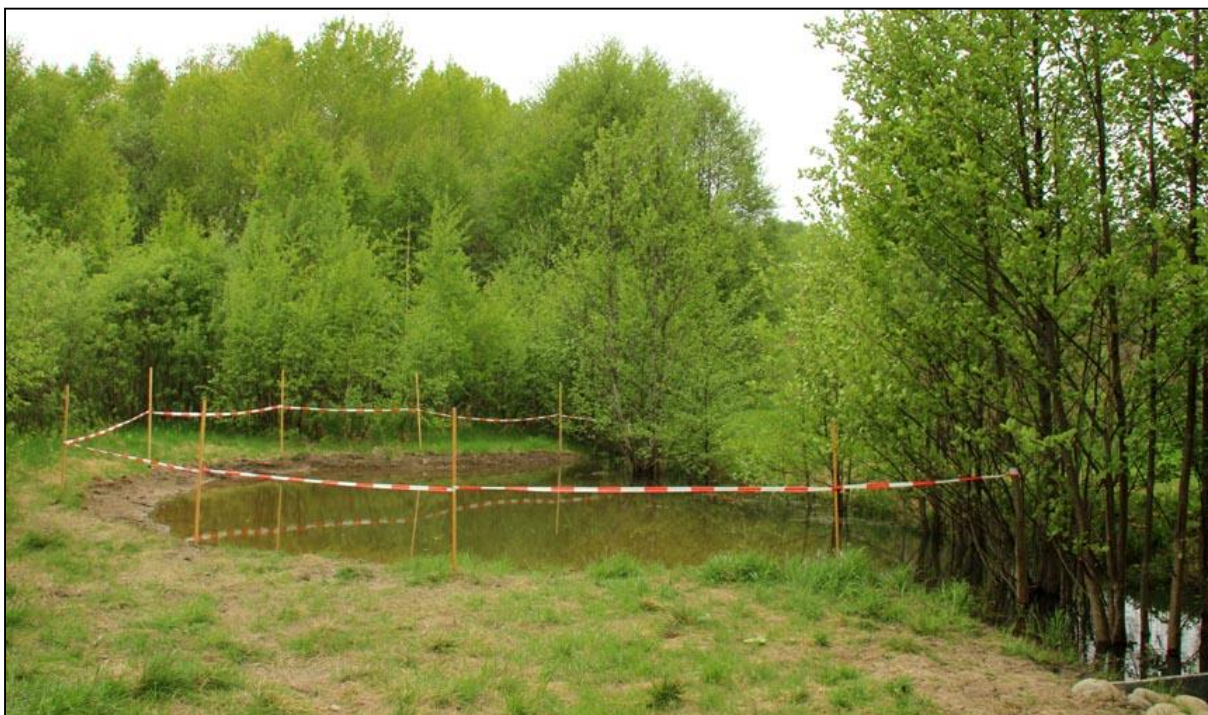
Figur 16. Dammen i Ormkärrskogen, våren efter utförd åtgärd.
