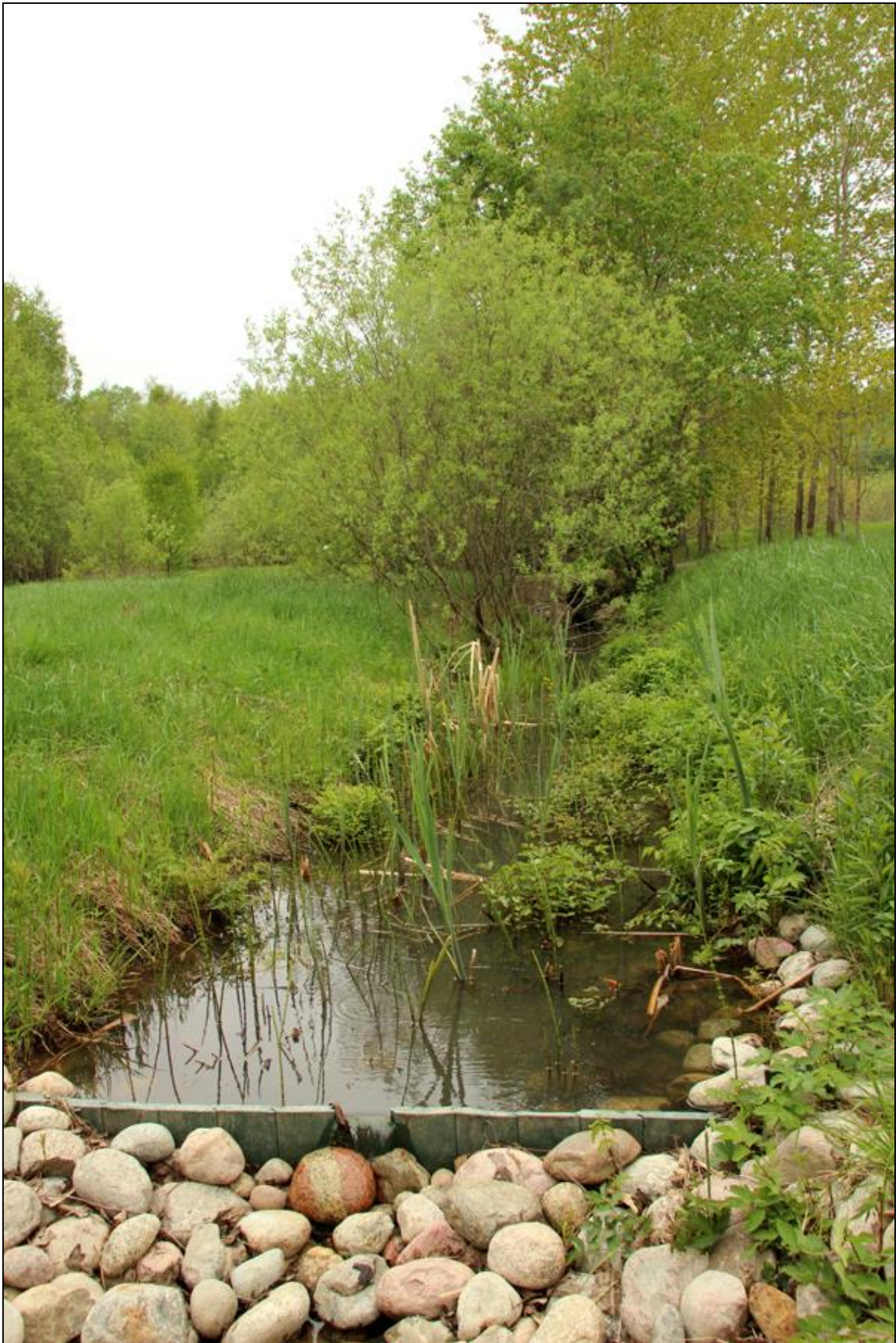
Figur 17. Dämme längst bäckfåran i Ormkärrskogen, våren efter utförd åtgärd.
