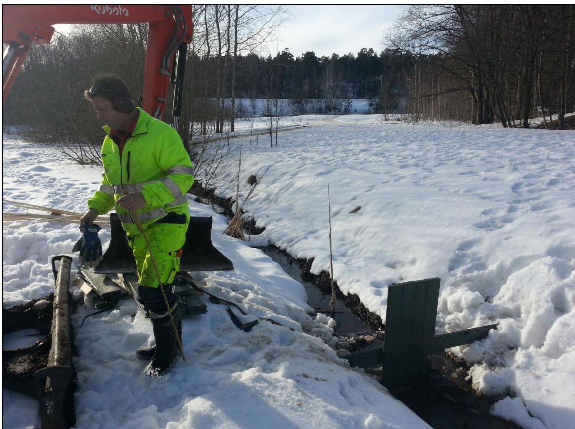
Figur 24. Arbetet pågår med dämmena i Ormkärskogen
