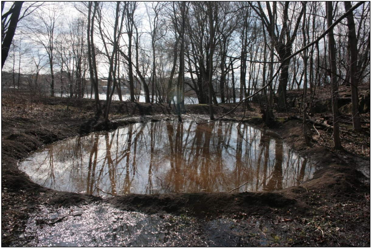
Figur 7. Bilden visar lokalen vid maximalt vattenstånd. Vid fototillfället är dammduken inte på plats, dammen är alltså inte färdigställd.
