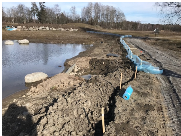
Figur 5. Bild till vänster: ett plaststängsel har grävts ner i marken omkring dammen för att förhindra att djur vandrar tillbaka till Louddens damm. Bild till höger: en pump har installerats för att tillföra vatten till dammen för att säkerställa att dammen inte torkas ut.
