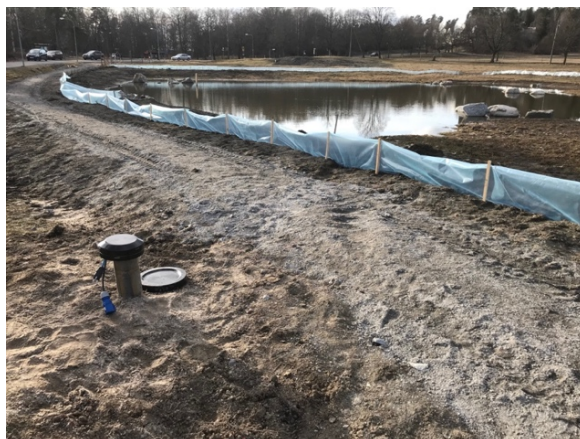
Figur 5. Bild till vänster: ett plaststängsel har grävts ner i marken omkring dammen för att förhindra att djur vandrar tillbaka till Louddens damm. Bild till höger: en pump har installerats för att tillföra vatten till dammen för att säkerställa att dammen inte torkas ut.
