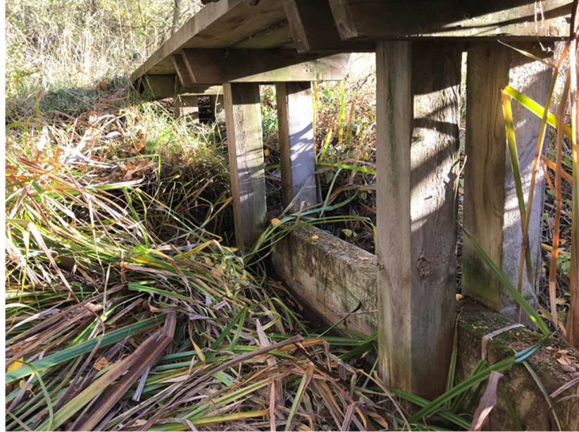
Bild 4. Dämnet består av en fast träkonstruktion. Åtgärdsförslaget innebär att ytterligare en bräda byggs på och där den mittersta delen ska kunna vara reglerbar.
