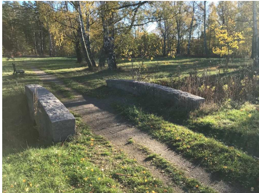
Bild 7. Tre stenbroar finns. Vattendraget är igenväxt och under broarna finns tjocka sedimentlager. Genom att rensa upp och genomföra biotopvård (tillförsel av sten) vid broarna kommer de fram mer i landskapet.
