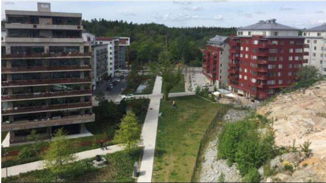
Figur 3. Bilden visar den nya parken, kallad Hästhagsparken, som utgör ett av få spridningsstråk som finns mellan Hjorthagskransen och Nationalstadsparken. Bilden är tagen från öster mot Nationalstadsparken. Centralt syns en grövre ek som det lades mycket ansträngning att spara när Detaljplan Västra Djurgårdsstaden byggdes.
