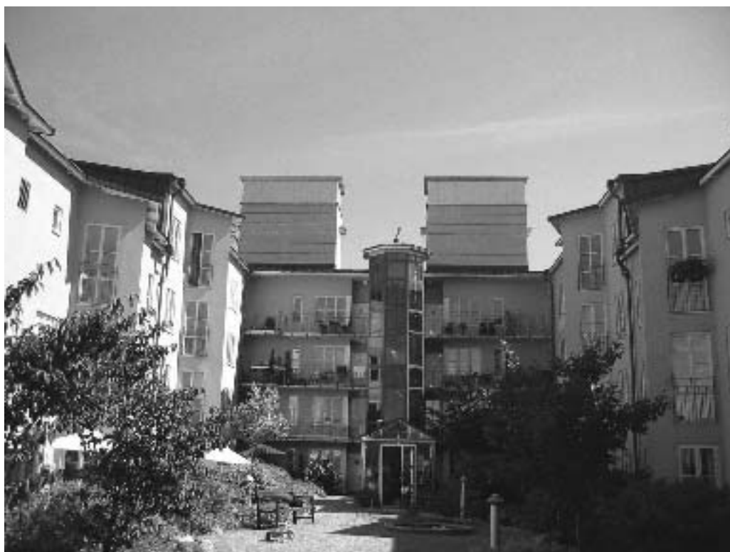
En välskött gård uppe på taket mitt i staden. De boende i undersökningsobjektet når gården via trappor eller hiss. Fläktar på taket har tidvis varit igång på grund av arbeten i Klaratunneln. Ett svagt trafikbuller hörs på gården.
