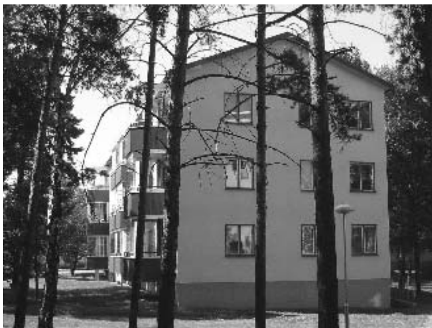
Fastigheten ligger vid Helenelunds tågstation där tågen orsakar mycket ljud trots bullerplank vid banvallen. På baksidan av husen har burspråk byggts till i samband med en renovering av fastigheten, för att möjliggöra vädring mot tyst sida.
