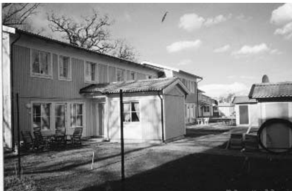
Fastigheten utgörs av radhuslängor där varje bostad har sin egen gård. Mellan gårdarna finns plank, som mest fungerar som insynsskydd.
