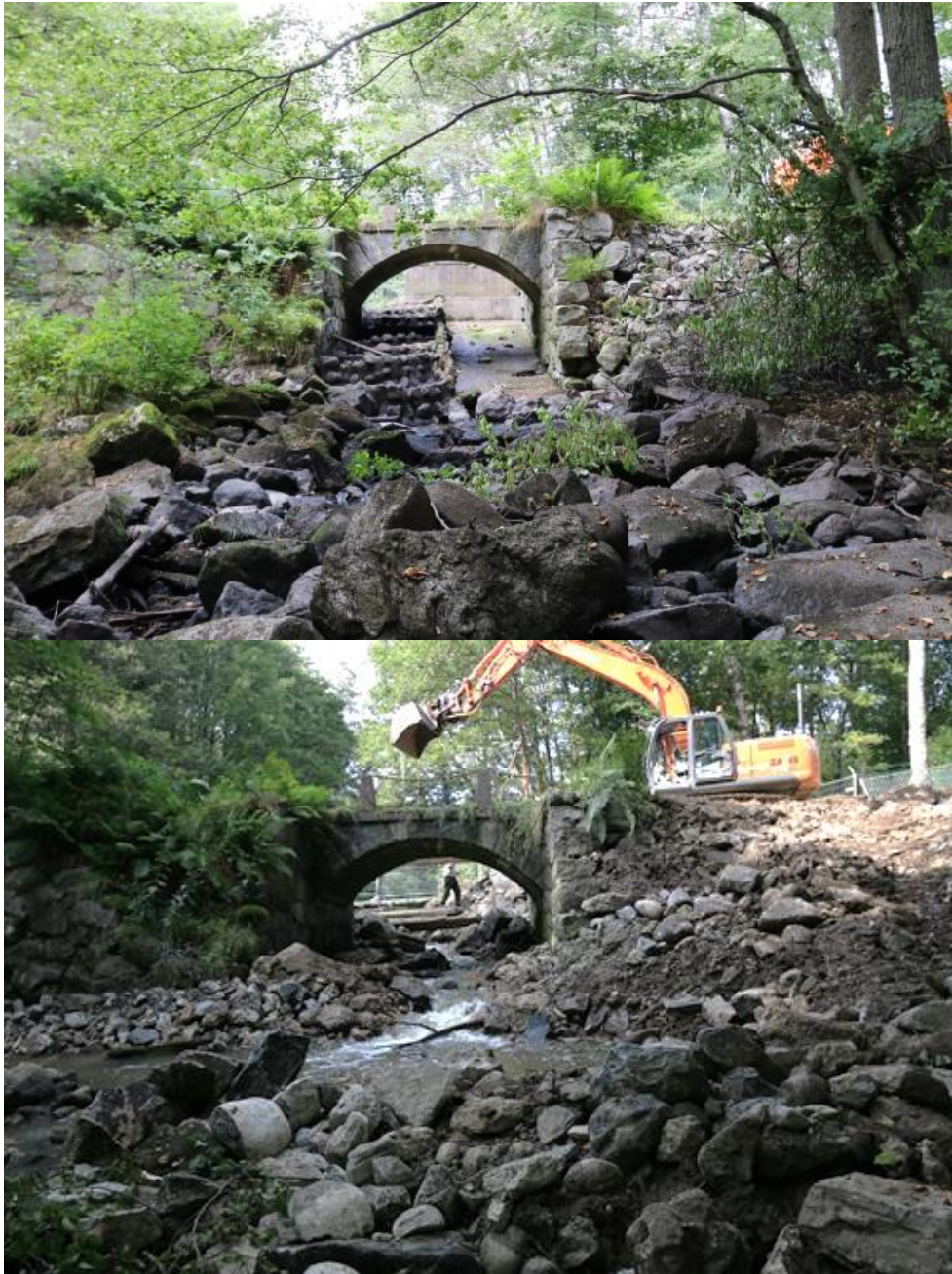
Figur 3: Vid Vitså kvarndamm i Vitsån revs ett betongskibord och en dåligt fungerande fiskväg ut under hösten 2015. Endast starksimmande leköringar som kunde hoppa mellan poolerna klarade av att forcera den gamla fiskvägen när flödena i vattendraget var optimala under hösten. Efter utrivning kan samtliga fiskarter av alla storlekar röra sig fritt i vattendraget under hela året. Rivningen av dämnet påverkade inte kulturmiljöintresset då endast betong togs bort vilket varit en efterkonstruktion på dämnet.
