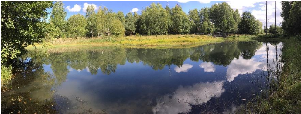
Figur 25. Dammspegeln uppströms dammen.
