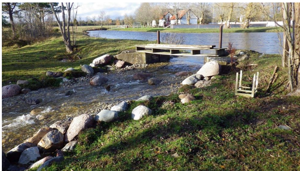
Figur 12: Bilden visar en restaurerad åsträcka som trösklats. Tidigare hindrande en damm fiskvandring. Vandringshindret togs bort och strömsträckan nedströms trösklades för att bibehålla vattennivån i vattenspegeln uppströms.
