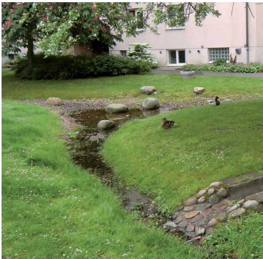
Ett svackdike på en dagistomt är exempel på en mångfunktionell yta. Åtgärder för att förebygga översvämningar kan bland annat bidra till en trevligare närmiljö. Foto Anette Björlin.
