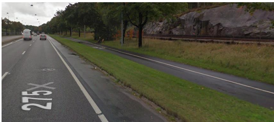
Figur 13 – Figur Bergslagsvägen, södra sidan. Källa Google maps.
