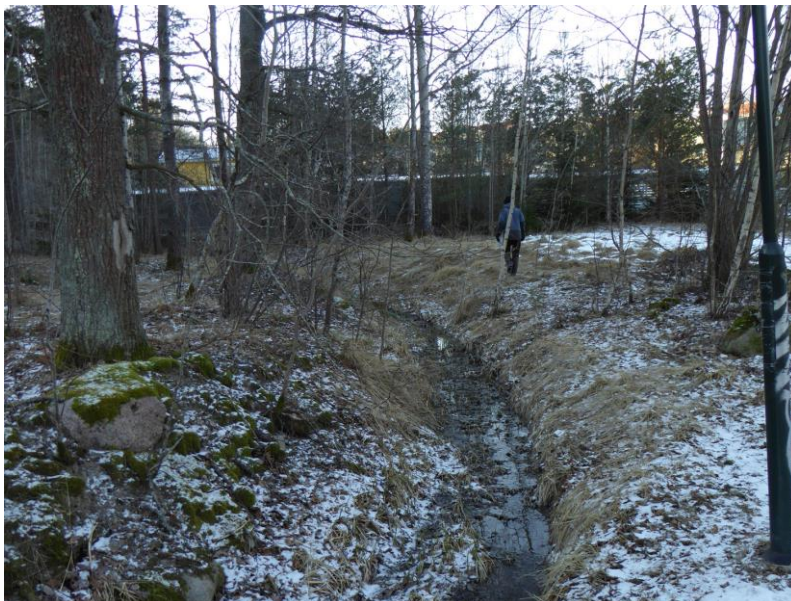
Figur 48. Dagvatten från Kortvingevägen och dess bostäder avleds i ett öppet dike som kan utvidgas till en damm. Foto mot söder.
