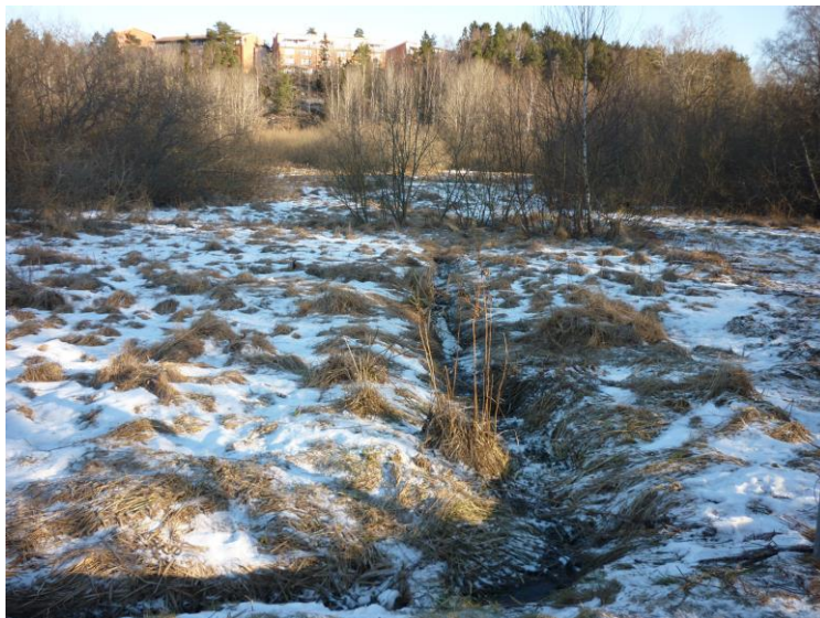
Figur 14. Dagvatten från bostadsområdet Myrängen leds i ett öppet dike sista sträckan ner mot Kräpladiket. Foto mot norr.
