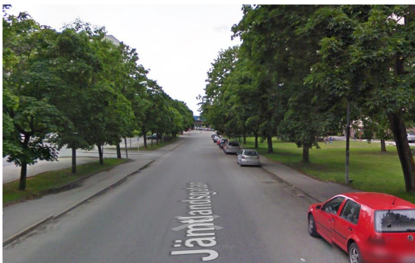
Figur 22 Bild på dagsläget, curb extensions anläggs på högra sidan av vägen mellan parkeringar.
