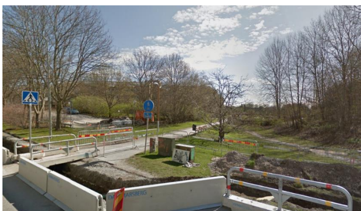
Figur 20 Bild på dagsläget, magasinet anläggs till höger om gång- och cykelbanan, eventuellt delvis under.
