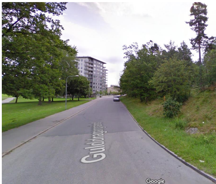
Figur 30 Nulägesbild, diket anläggs på den högra sidan i släntfoten.
