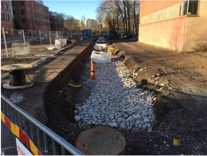
Figur 10. Exempel på etablering av skelettjord utmed en gata i befintlig miljö.
