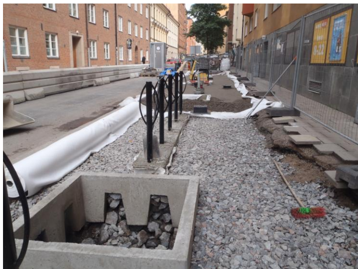
Figur 9. Exempel på etablering av skelettjord i befintlig miljö i Stockholm. Foto Björn Embrén Trafikkontoret.
