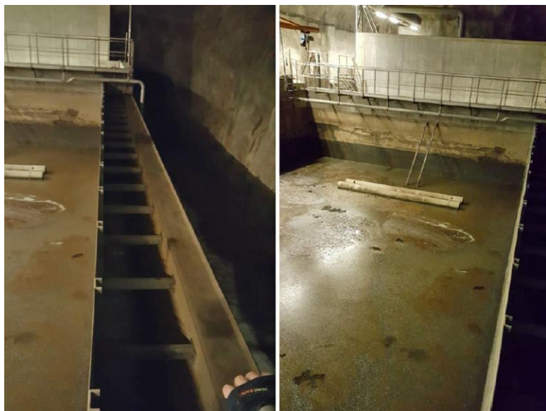
Figur 39. Brädd-skibord (till vänster) och dekanter som förhindrar att ytslam och oljerester följer med (längst bak till höger) från sedimenteringsbassängen. Foton: Jonas Sundgren (okänd organisation)
