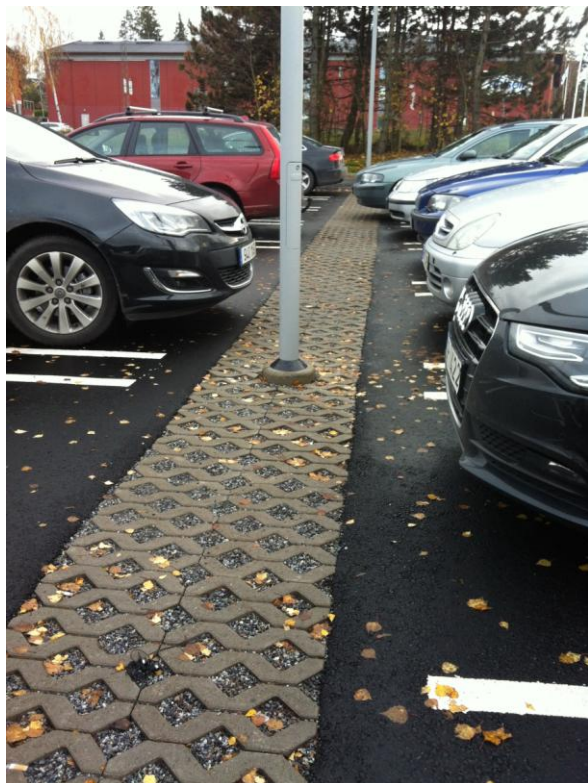
Figur 6. Parkeringar kan LOD:as med betonghålsten.
