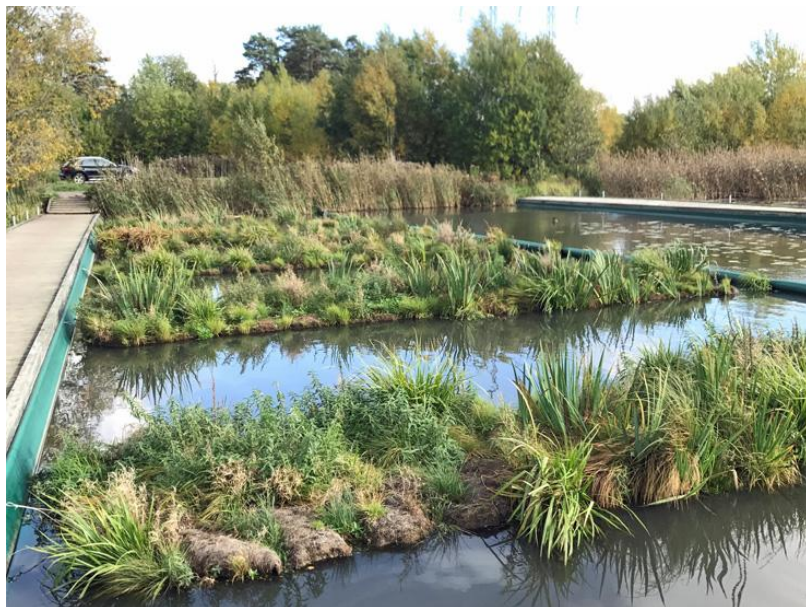
Figur 24. Skärmbassängen i sjön Trehörningen i Huddinge kommun har kombinerats med flytande öar med strandvegetation. Foto: Urbangreen.
