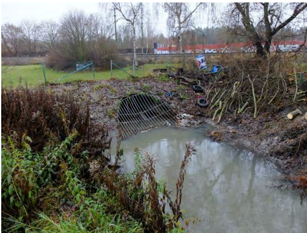
Figur 20. Vid vandringshinder VH3:2 finns spår av bråte som fastnat i gallret. Foto: Emåförbundet
