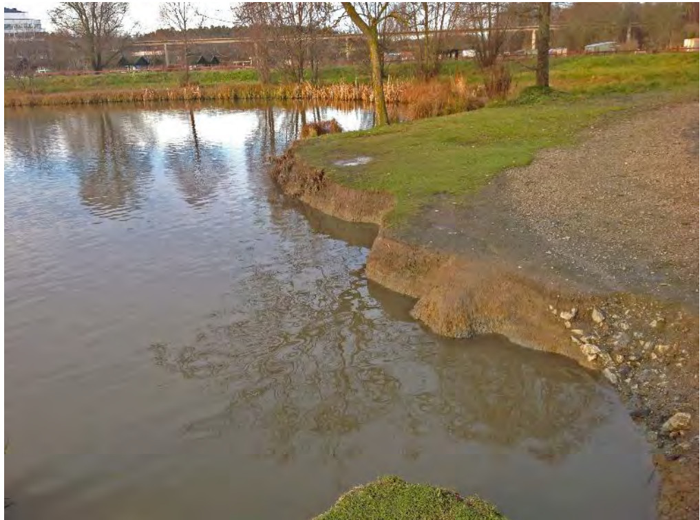
Figur 24. Kraftiga erosionsproblem i Hjulsta vattenpark
