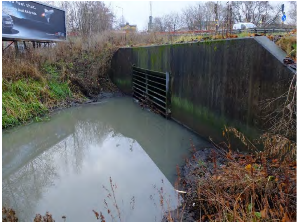
Figur 16. Vandringshinder VH2:2 utgörs av gallret vid inloppet till en kulvert. Foto: Emåförbundet
