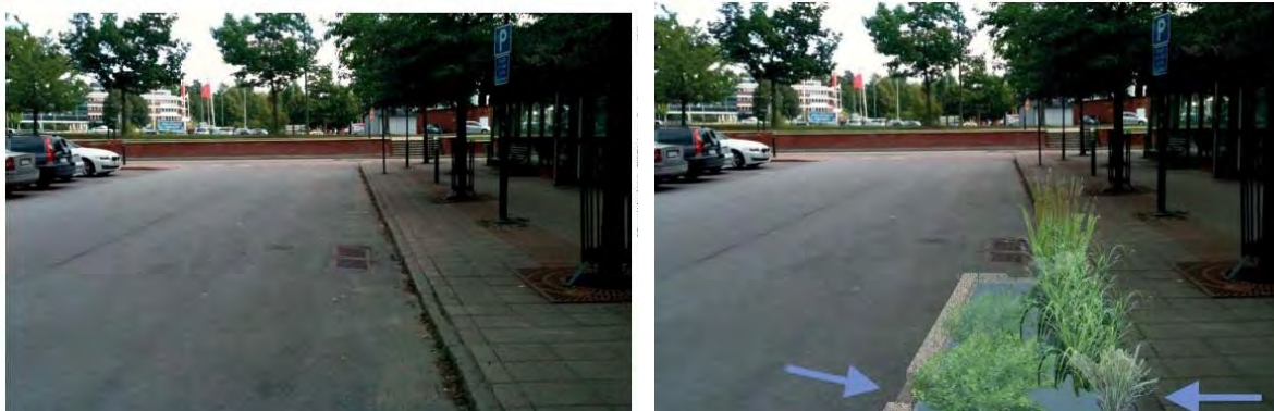
Figur 10: Åtgärd för dagvattenhantering före (t.v.) och efter (t.h.).
