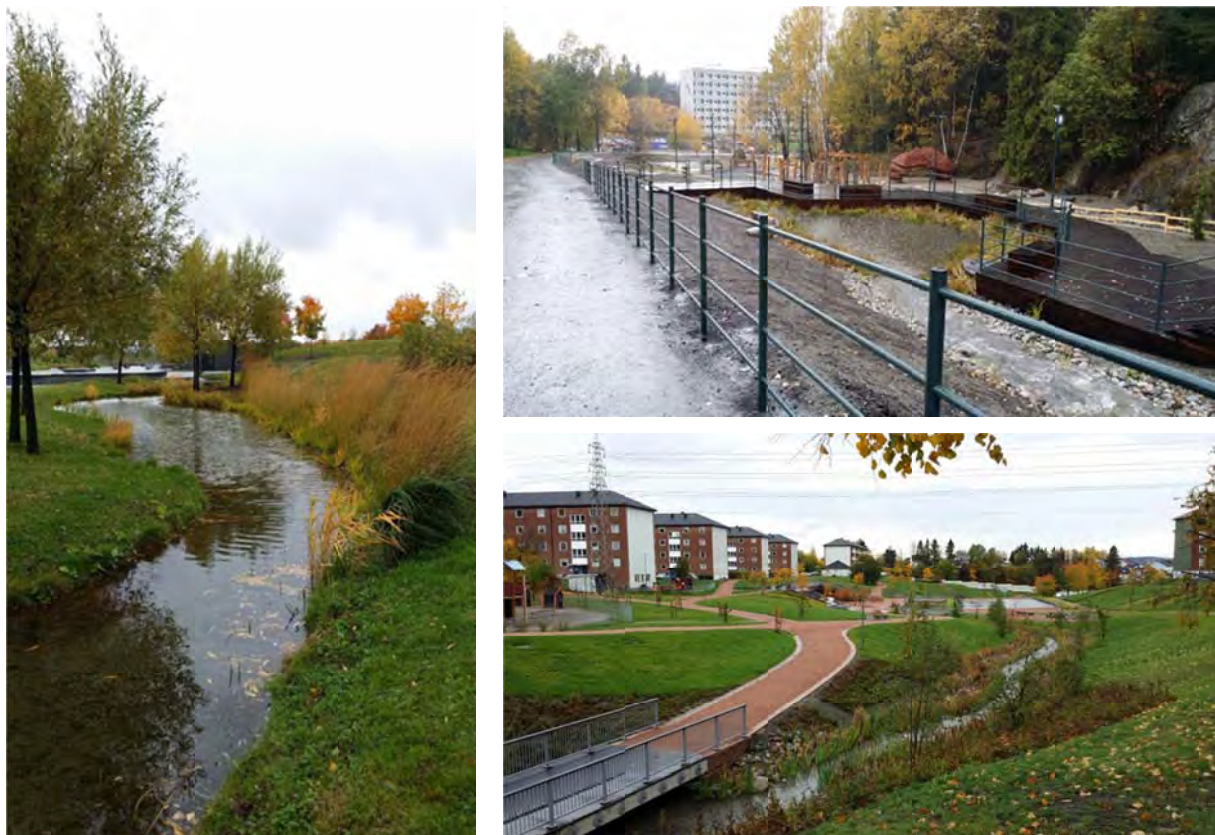
Figur 13: Exempel från Oslo på breddning av befintlig å och anläggning av grundzoner med våtmarksväxter.
