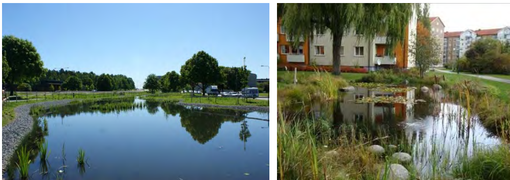
Figur 11: Exempel på dagvattendamm i anslutning till väg och i ett bostadsområde.
