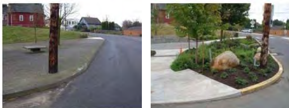
Figur 9: Åtgärd för dagvattenhantering före (t.v.) och efter (t.h.).
