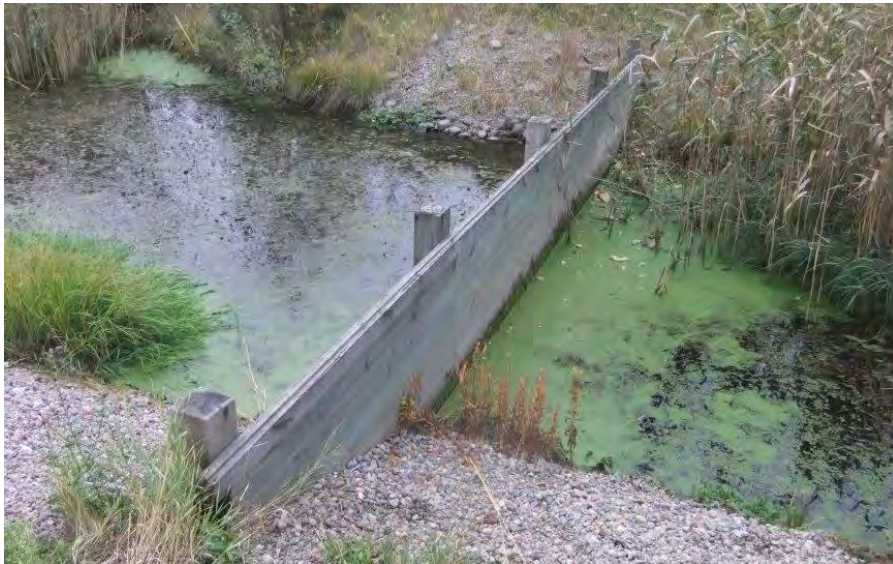
Figur 18. Oljeavskiljande skärm vid inloppet till Visingedammen i Täby. Foto Sofia Åkerman 2016-10-12.
