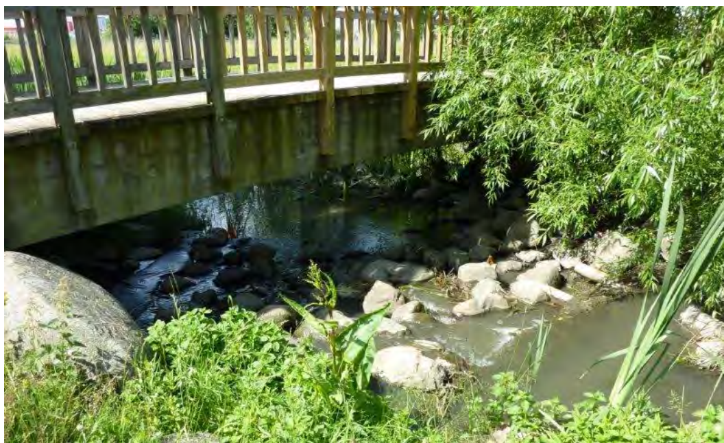
Figur 8. Utloppet över skibord 3 (utloppet från damm 2) och bron däröver. Foto: Sofia Åkerman 2016-06-22.
