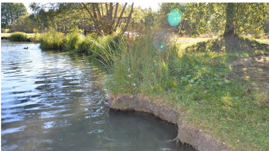
Figur 10. Erosion av strandkanten i damm 1. Där det växer starr (halvgräs) fungerar dessa som erosionsskydd, se längre bort i bilden. Foto Sofia Åkerman 2016-10-06.
