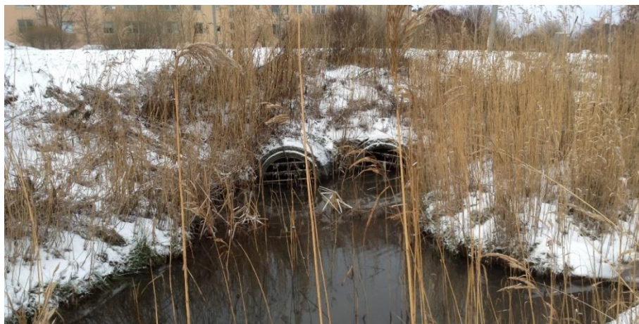
Kulvert under Spångavägen. Foto: Ekologigruppen
