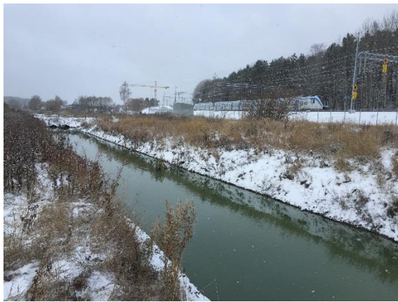
Figur 3. Provpunkt Bä 50. De branta slänterna medförde att provtagningsmetod fick styras av säkerhetsaspekter.
