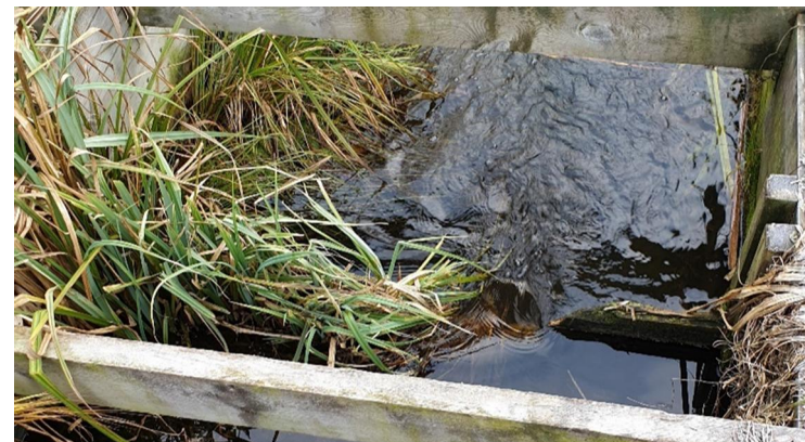
Fig 10. Fotot ovan är från Nynäshamns våtmark där bävern bitit sönder en av plankorna som reglerar flödet mellan två dammar. I Nynäshamn har driften tillsyn flera gånger i veckan för att upptäcka och åtgärda ingrepp i ett tidigt skede samt för att rensa växtlighet som kan stoppa upp flödet. Vid några tillfällen har Nynäshamn från Länsstyrelsen fått tillstånd att spränga bäverbon som anlagts i våtmarken. (Foto: Johanna Lundström 2019-11-06)
