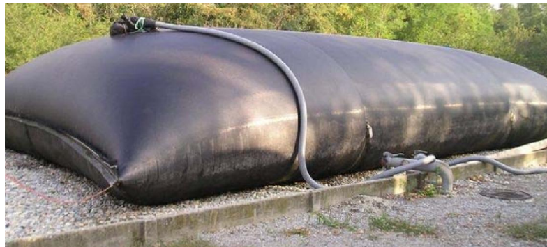
Fig 8. Exempel på geotub. Källa: https://vpp.sbuf.se/Public/Documents/ProjectDocuments/442015b4-3dcc-469f-9baf-81a128d12f29/FinalReport/SBUF12327%20Slutrappport%20Geotuber%20för%20slamavvattning%20vid%20anläggningsarbeten.pdf
