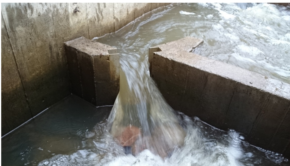
Bild 4: Nedersta steget är för högt placerat. Notera höjdskillnaden och vattnets tryck genom den allt för smala slitsen.
