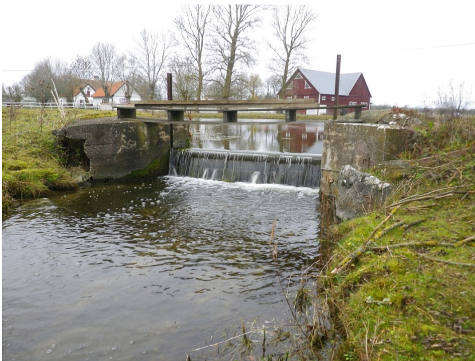
Bild 6: Exempelbild på vandringshinder.
