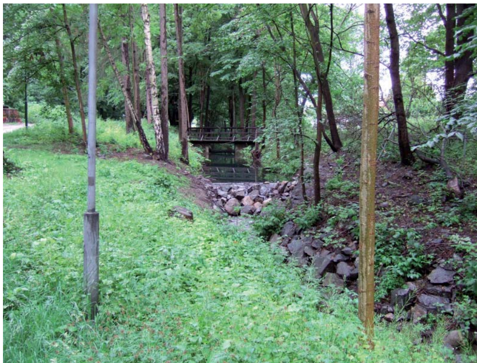
Den stenkädda betongdammen.
