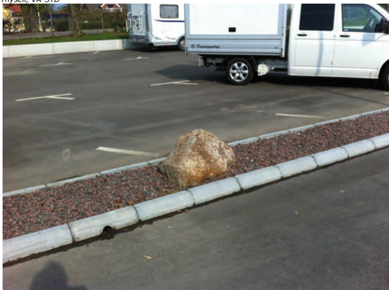
Asfalterad parkering med hålkantsten och dränerat infiltrationsstråk.
