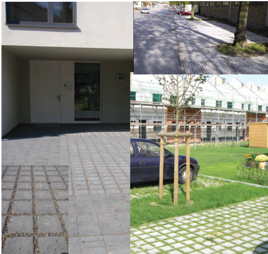
Markparkeringar med olika exempel på genomsläppliga beläggningar. Foto på Pelle-plattor med sorterad grus-/makadamfraktion överst till höger: Ulf Thysell, VASYD
