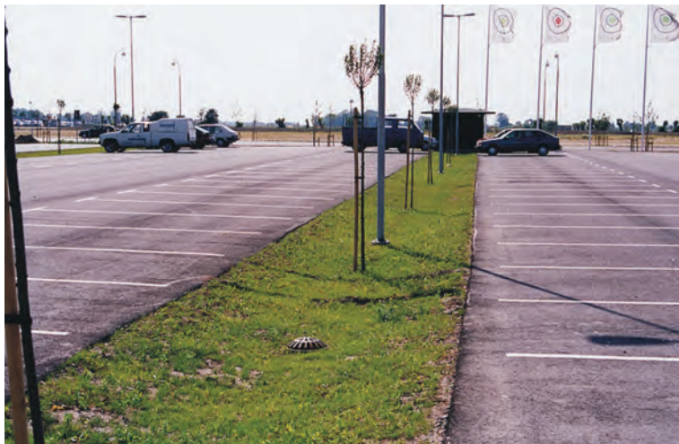
Köpcentrumparkering med dränerat infiltrationsstråk och upphöjt dagvattenintag. Foto: Ulf Thysell, VA-SYD
