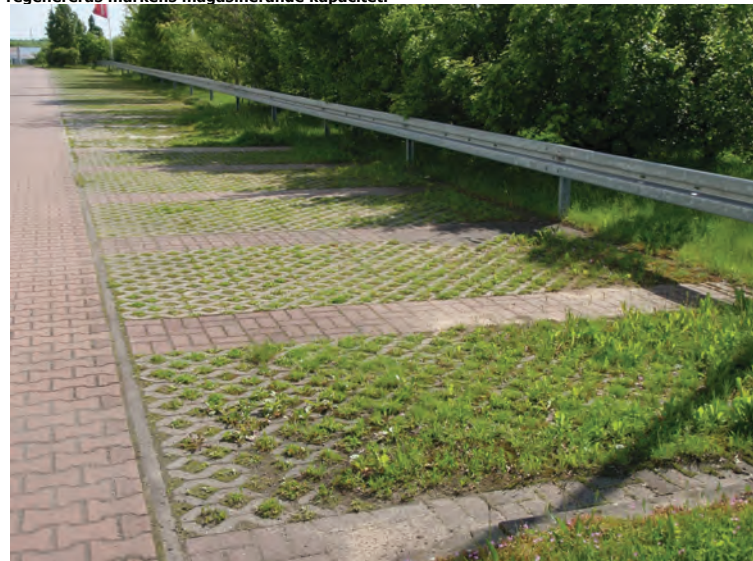
Markparkering med p-fickor med betonghålstensbeläggning.
