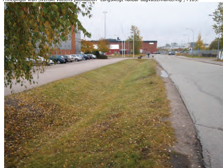
Öppet dike med flacka slänter i ett verksamhetsområde. Utformas gärna med upphöjt dagvattenintag. Öppna diken ger flödesutjämning, filtrering, sedimentation och biologisk nedbrytning. Dessutom utgör dikena tillfälliga magasiningsvolymer vid spill av diesel, olja eller kemikalier i samband med trafikolyckor.
