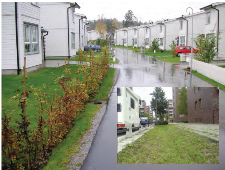
Bostadsgata utan kantsten eller gatubrunnar. Kantstenen har ersatts av stödremsa så att avrinningen kan avledas till och infiltrera i ett dräneringsstråk intill gatan. Det inskjutna fotot visar ett svackdike mellan gata och trottoar.
