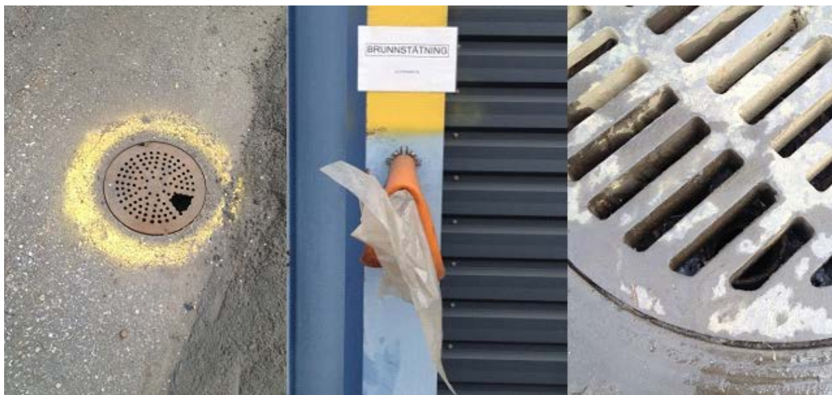
Figur 7. Bilden till vänster visar en dagvattenbrunn som är tydligt utmarkerad med gul färg, bilden i mitten visar på beredskap för brunnstättning med plastduk. Bilden till höger visar en dagvattenbrunn med filter och oljeavskiljare.
