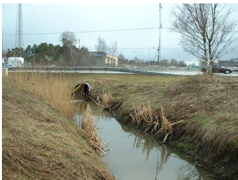
3. Veddesta dike. Kulvert under E18. Provet tas precis utanför kulverten.
