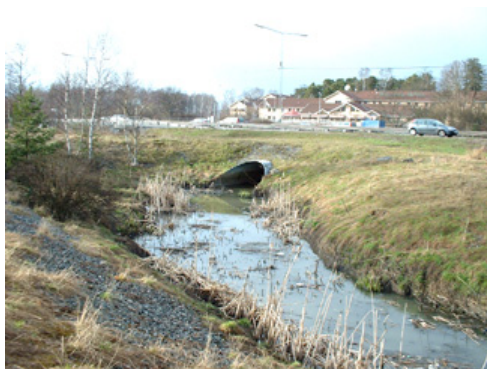
4. Nedströms Veddesta dike. Kulvert under E18 efter Welcome hotel (i bakgrunden).
