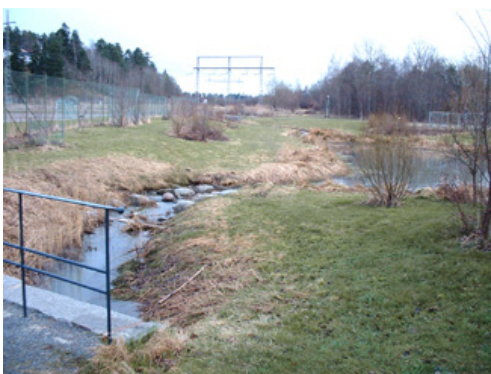
9. Nälsta dike. Utflödet från den övre dammen i Bällstaåpark.
