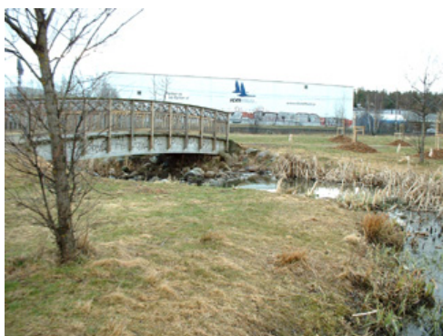
6. Nedströms Hjulsta vattenpark. Dämme efter den nedre dammen.
