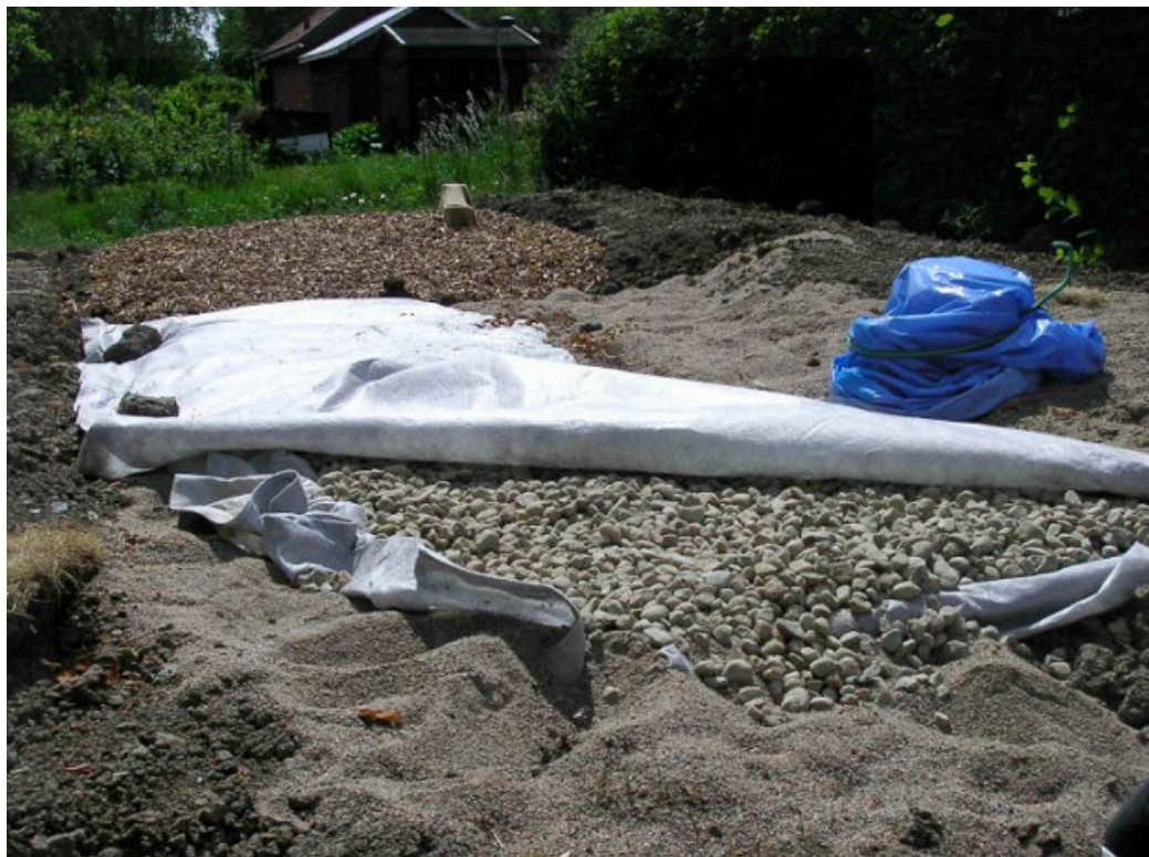
Figur 4. Filterbädden för duschvattenrening under byggnation maj 2007.
