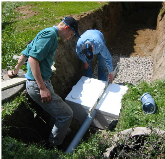
Installation av kompaktfilter. Källa:
