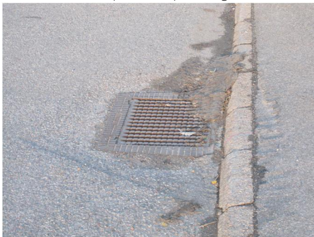
Bild 3 Exempel på en dagvattenbrunn i gatan.
