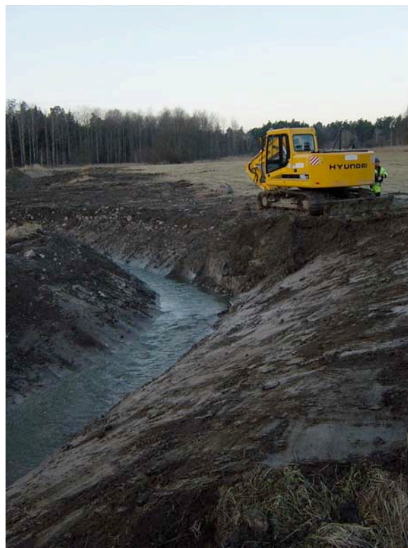
Fig. 9. Pågående restaurering av Igelbäcken 2005–2006. Nya meanderslingor grävs och nytt botten substrat tillförs bäcken. [Ongoing restoration, habitat improvement, in Igelbäcken stream during 2005–2006.] Foto: Stefan Lundberg
