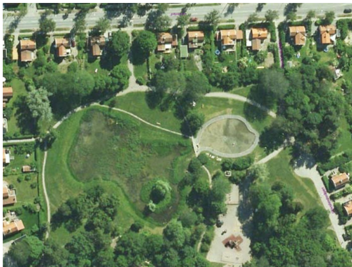
Figur 3. Olovslundsdammen med den angränsande plaskdammen till höger i bilden. Muren längs den västra kortändan (till höger i bild) var inte uppförd vid fotograferingstillfället. Ortofoto från Stockholms stadsbyggnadskontor.
