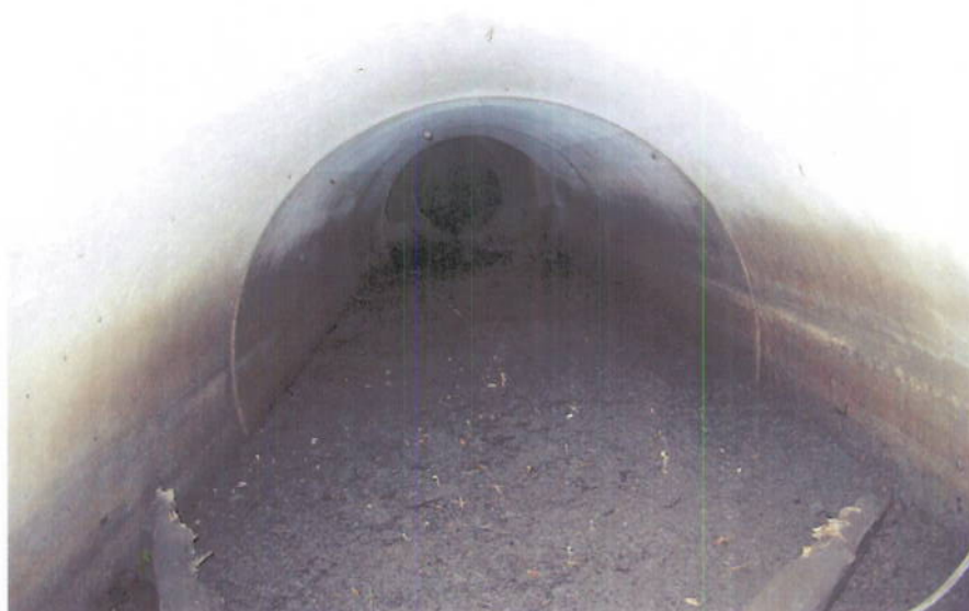
Figur 6 Dagvattenledningen vid utloppet till diket vid Bällstavägen.
