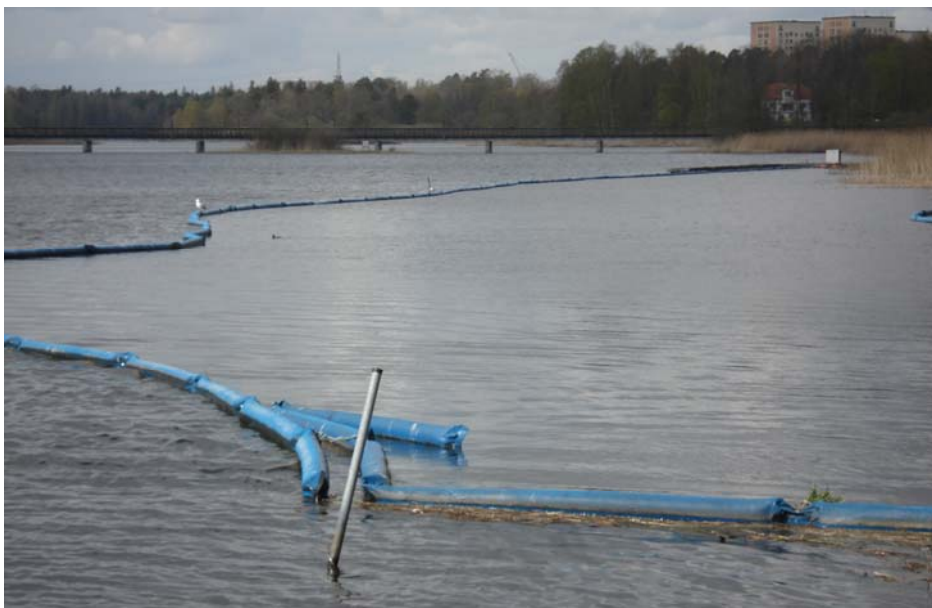
En skärbassäng, en sjöförlagd reningsanläggning för dagvatten i Magelungen. Foto Iréne Lundberg.
