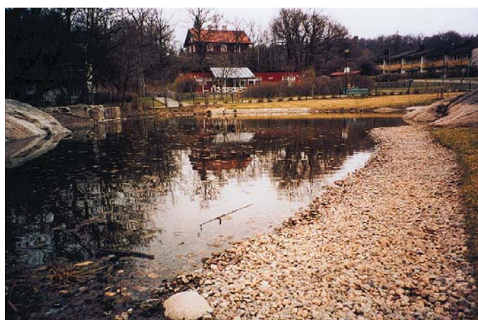
Figur 9. Dammen i östlig riktning den 3 oktober 2004.
