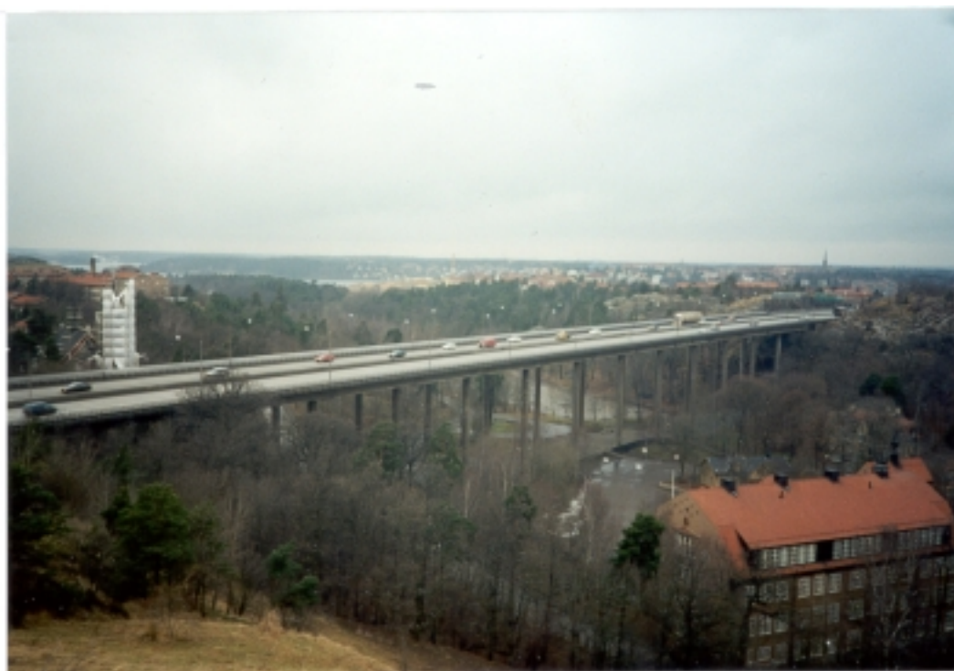
Figur 2.6 Motorvägen Essingeleden, Blommensbergsviadukten, taget mot nordväst från Nybohovsberget (Foto: Larm T, VBB VIAK).
